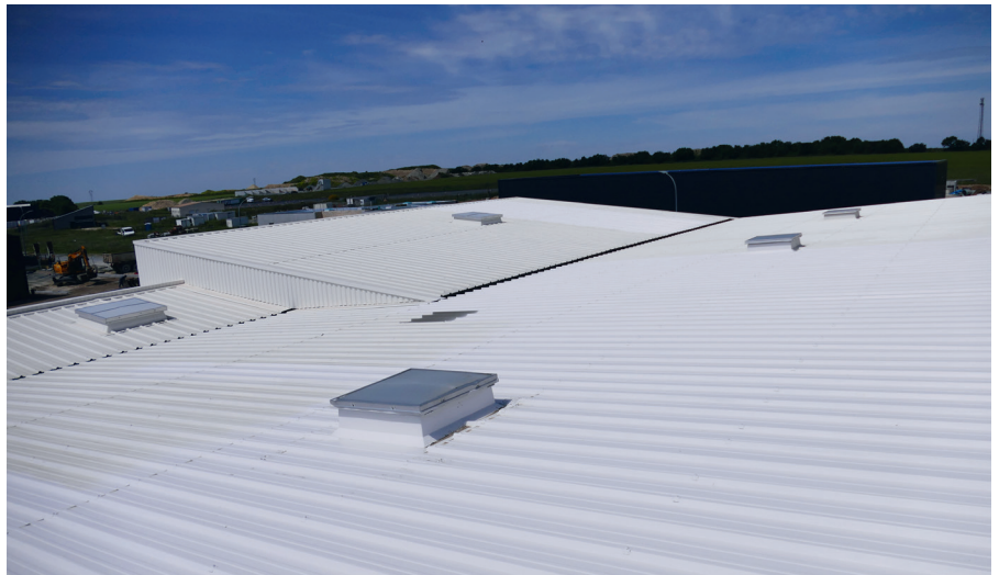
Toit couvert de peinture qui réfléchit.
